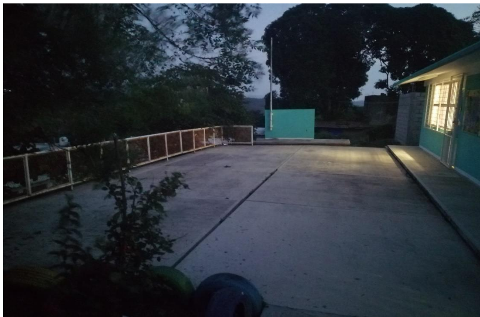
Separación de piso debido al hundimiento de terreno. Fotografía tomada en atención a reporte en el año 2019 atendido por la unidad de Protección Civil Municipal.
