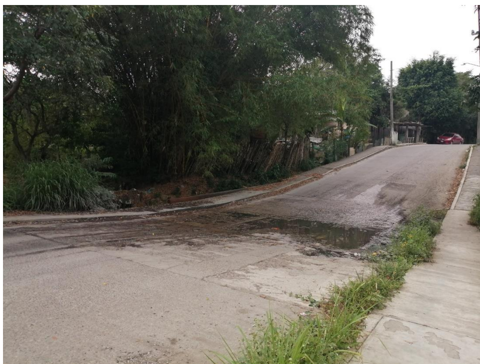
Hundimiento de terreno que ocasiona anegación de agua. Fotografía tomada en atención a reporte en el año 2020 atendido por la unidad de Protección Civil Municipal.
