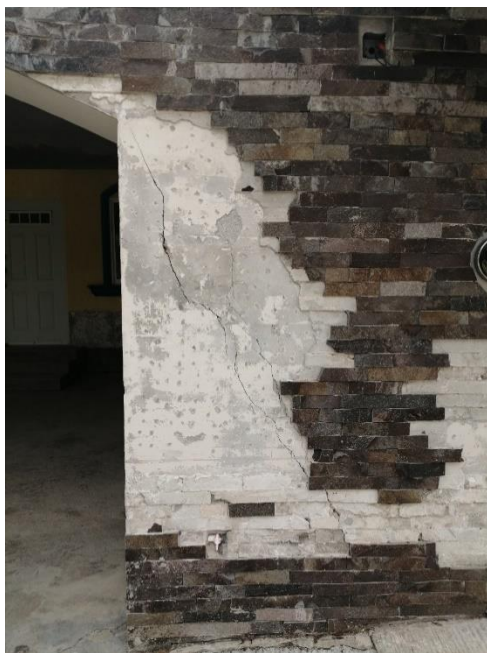
Agrietamiento en muro de domicilio del fraccionamiento Fincamex, debido al hundimiento natural en la cual fue construida la vivienda.
