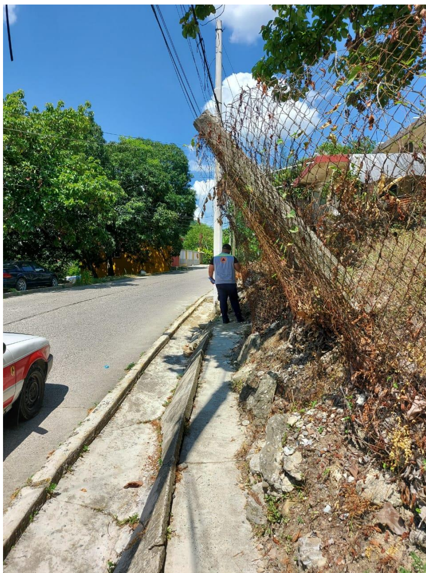
Deslizamiento de tierra hacia la calle, debido al grado de inclinación del terreno. Fotografía tomada en atención a reporte en el año 2020 atendido por la unidad de Protección Civil Municipal.
