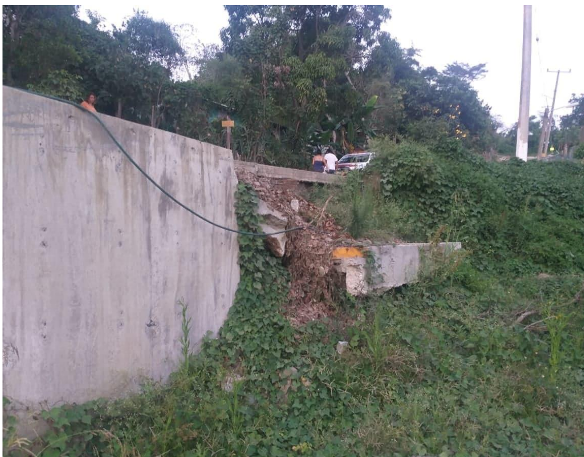
Deslizamiento a causa de fractura en muro de contención en la localidad Cerro del Mesón. Fotografía tomada en recorrido de campo hecho por la unidad de Protección Civil Municipal durante el año 2020.
